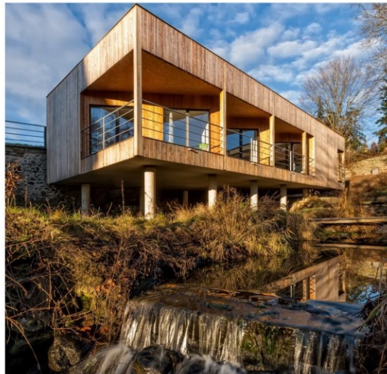
Obr. Moderná drevostavba ( https://www.archiweb.cz/b/dum-nad-vodopadem )
