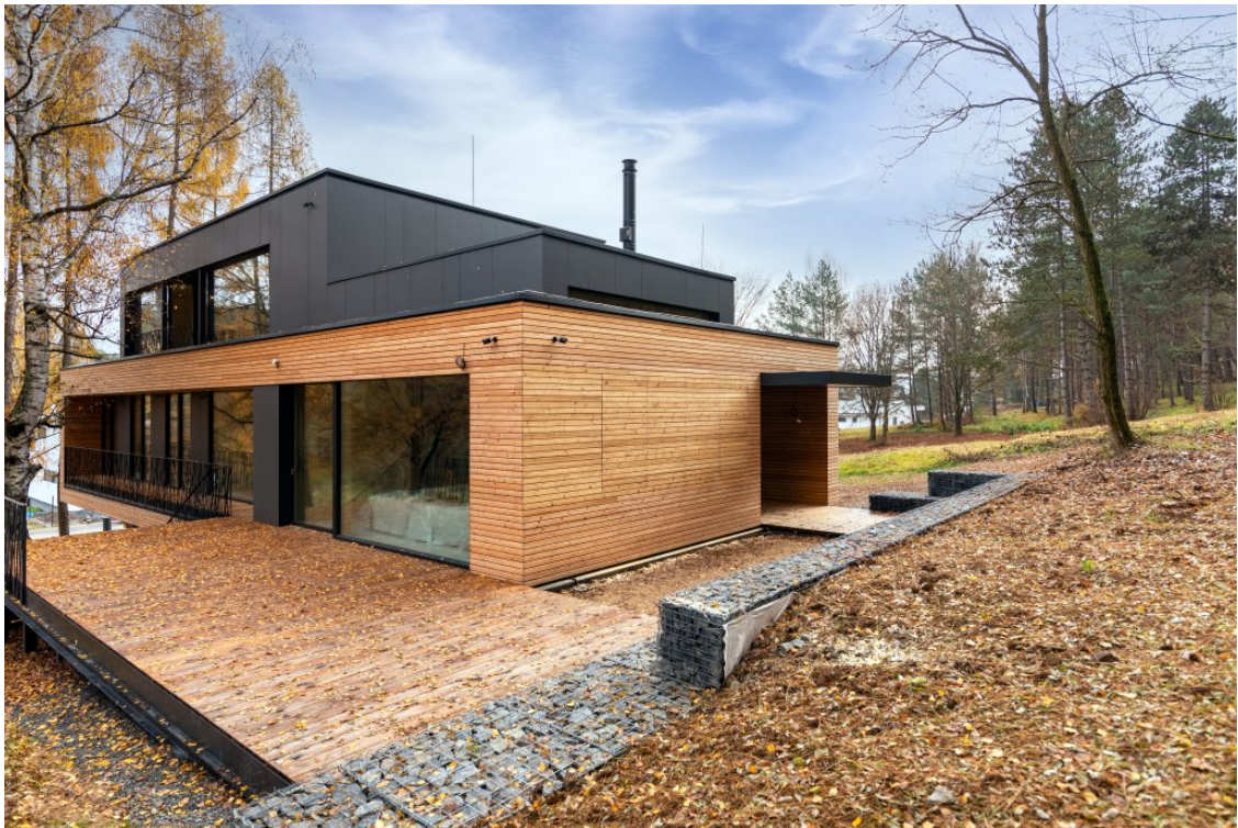
Obrázok 6 Príklad drevostavby z CLT panelov [11]
