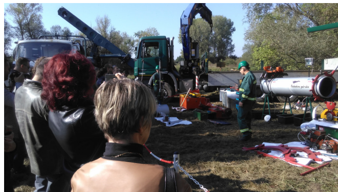
Ukážka techniky údržby ropovodu
