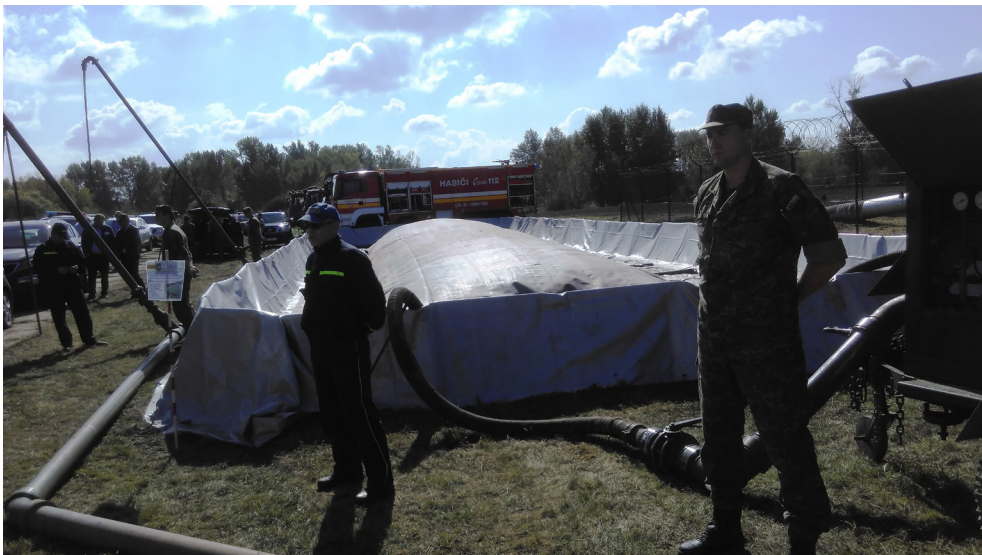
Výstavba poľného diaľkového potrubia PDP -150
