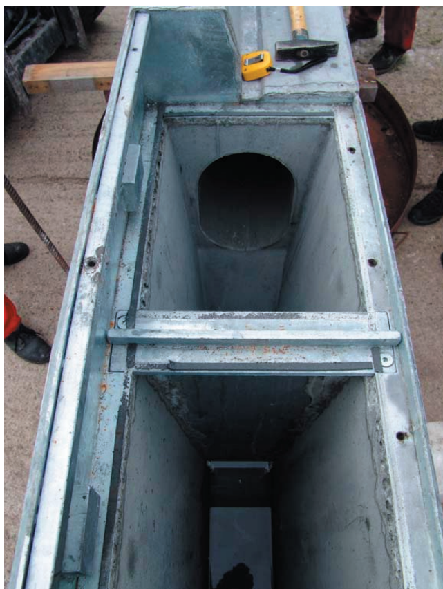
Obr. 6 – Požární uzávěr – kanalizační protipožární přepážka
