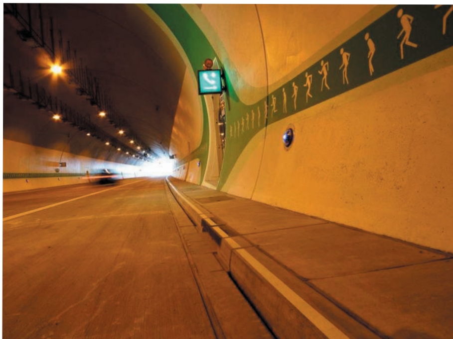
Obr. 8 – Systém odvodnění štěrbinovými žlaby v tunelu Valík
