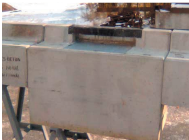
Obr. 4 – Požární uzávěr – kanalizační protipožární přepážka
