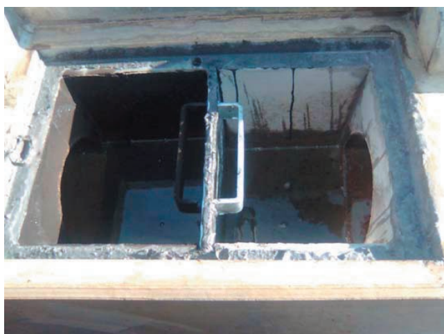
Obr. 7 – Požární uzávěr – kanalizační protipožární přepážka
