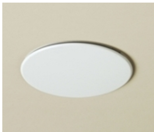
Obr. 6 – Ukázka zapuštěné a zakryté zapuštěné sprinklerové hlavice [9]
