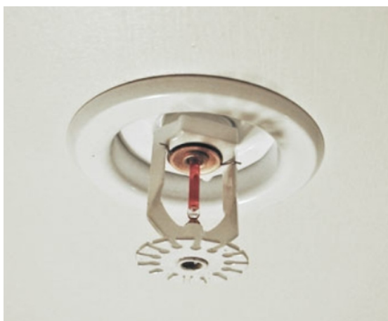
Obr. 6 – Ukázka zapuštěné a zakryté zapuštěné sprinklerové hlavice [9]
