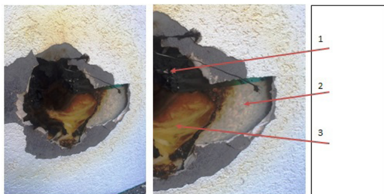
Obr. 9. Poškodenie izolačnej platne
