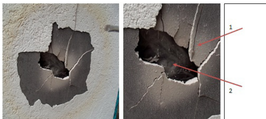
Obr. 10. Poškodenie celistvosti sadrokartónovej dosky a tepelnej izolácie
