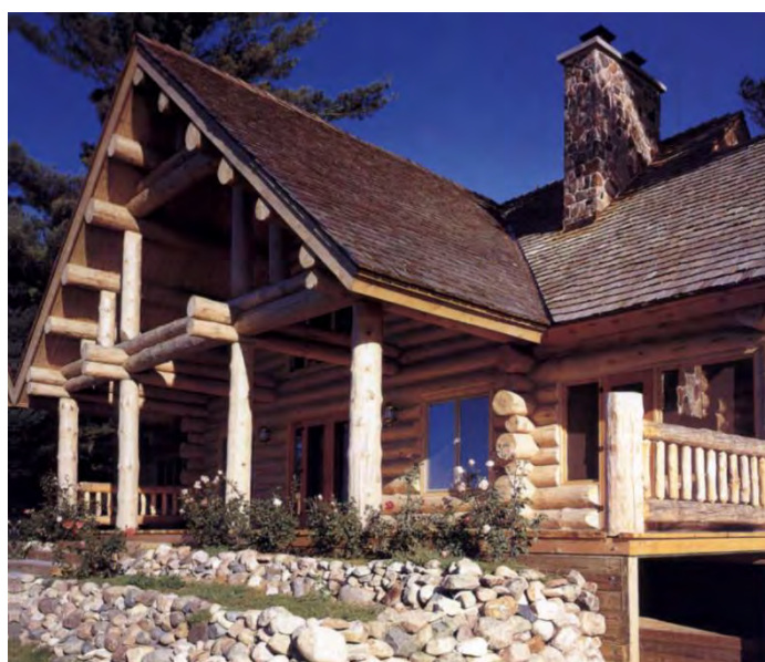
Obr. 3 Zrubová konštrukcia (Obomsanin 2001)
