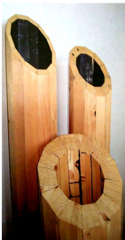
Obr. 9 Prierez dutého dreveného stĺpa (Štefko a kol. 2006)
