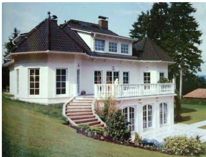
Obr. 6 Na prvý pohľad masívna tehlová stavba, v skutočnosti drevostavba z panelov (Štefko a kol. 2006)
