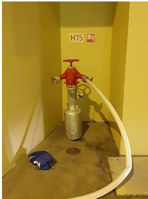
Obr. 16 Nadzemný požiarny hydrant (Zdroj: Autor)
