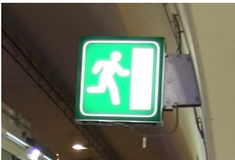
Obr. 11 Označenie vstupu do priečneho prepojenia (Zdroj: Autor)
