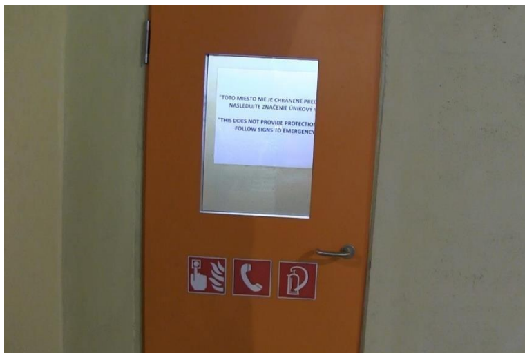
Obr. 19 SOS kabína (Zdroj: Autor)
