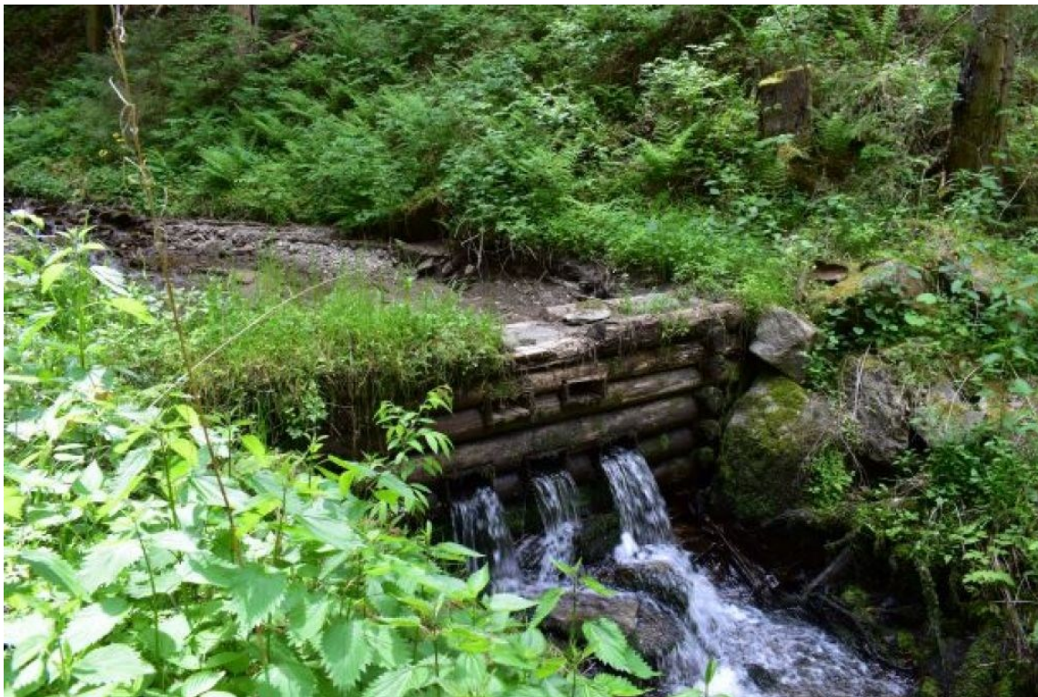
Prehrádzka v lesnom prostredí zachytávajúca povrchový odtok. Zdroj: LesMedium .
