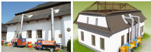
Obr. 1.: Sanace napadené konstrukce krovu
