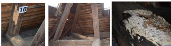
Obr. 2: Poškozené konstrukční prvky zámku Dolní Lutyně tesaříkem krovovým (*Hylotrupes bajulus* L.) a houbou popraškou sklepní (*Coniophora puteana*)
