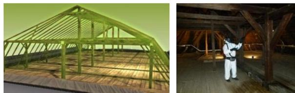
Obr. 16.: Ochrana insekticidní impregnací všech sanovaných dřevěných konstrukcí krovů
