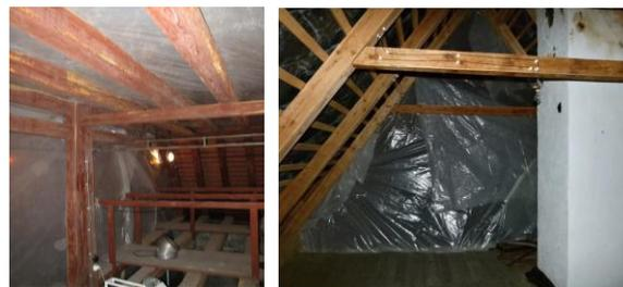
Obr. 6.: Zaizolování sanovaného prostoru
