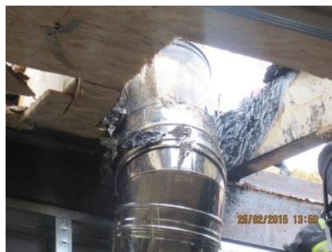
Obr. 5 Zlé konštrukčné riešenie prestupu dymovodu konštrukciou strechy
