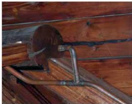
Obrázok 6 Medené potrubí sprinklerov splýva s povrchom starého dreva. Foto: Zelinger, J.
