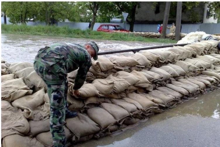
Obr. 10 Budovanie povodňových hrádzí (Zdroj: www.mosr.sk )
